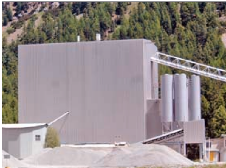
Die in der reizvollen Flusslandschaft von Montebello bei Pontresina im Engadin in den vergangenen Jahren neu erstellten Kies- und Betonanlagen fügen sich gut in die Landschaft ein. Fotos: H.PI.
